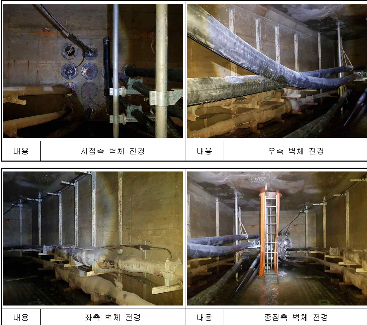
【사진 6.13】 문산~선유 #4 전경
